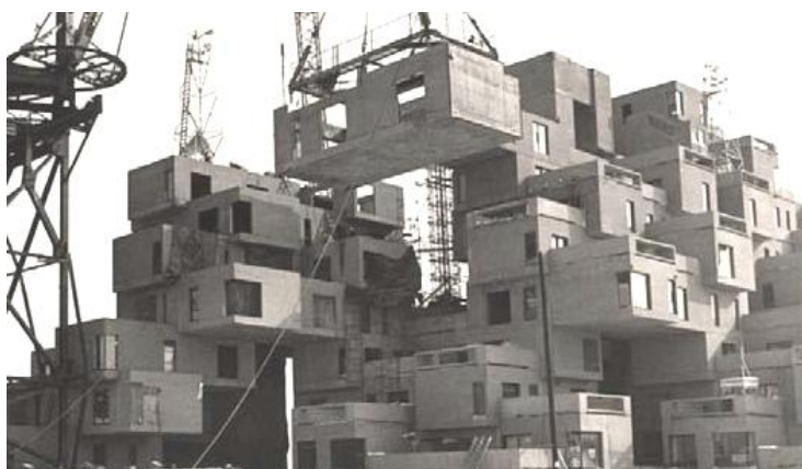
Рисунок 3 Монтаж элементов жилого комплекса «Habitat 67», Канада [1]
