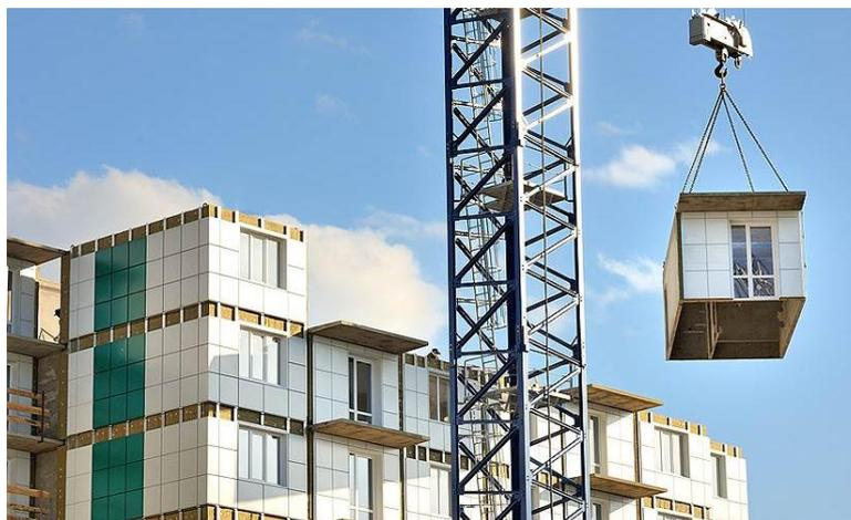
Рисунок 6 Монтаж современного железобетонного модульного-блочного элемента, Россия [1]
